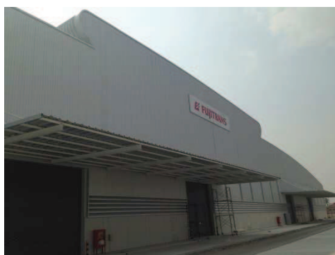
上屋搬出入口付近
