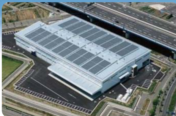
豊田物流センターの太陽光パネル
