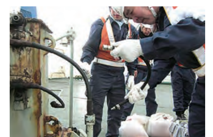
油流出防止のため部品を交換
