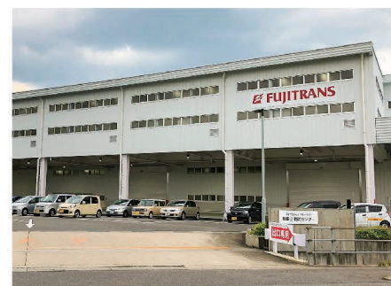
豊田物流センター 2号倉庫
