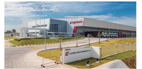
3棟目となる新倉庫
