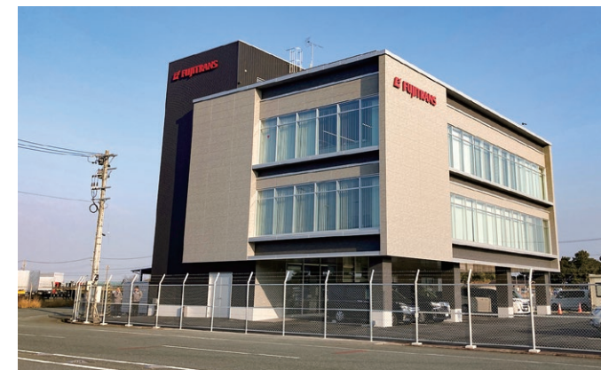
完成した新事務所
