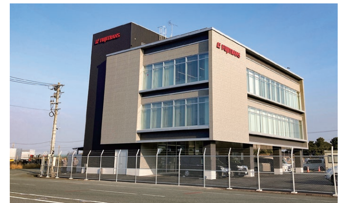
完成した新事務所
