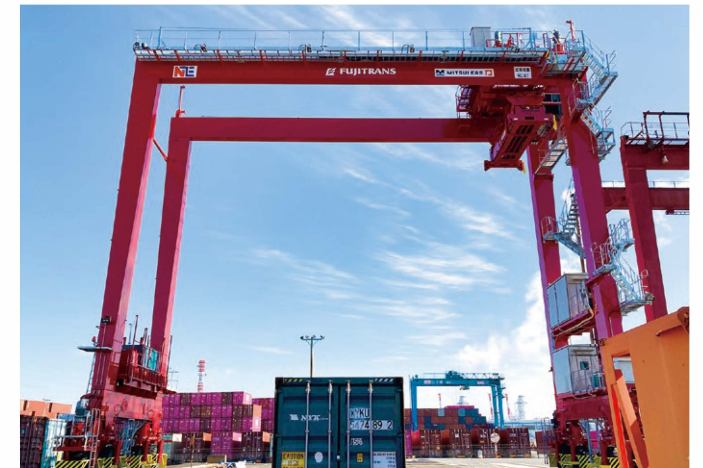
導入したトランスファークレーン
