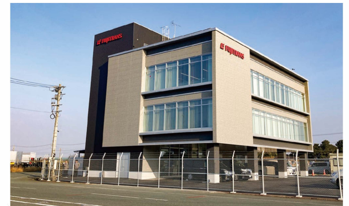
完成した新事務所
