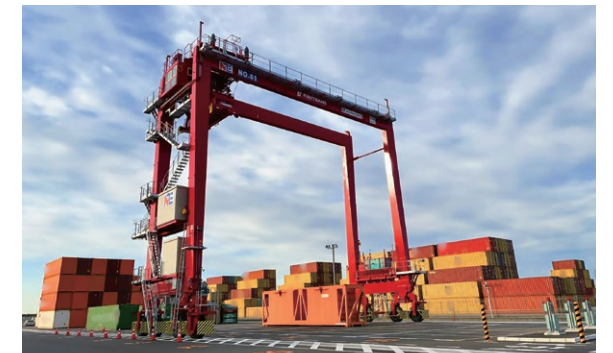
導入したトランスファークレーン
